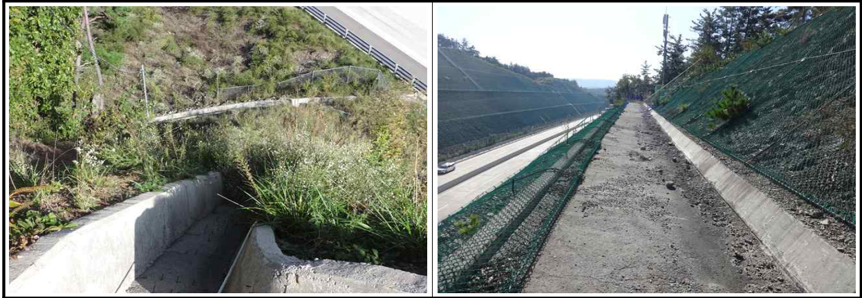
【그림 63.3.3】 배수시설 전경
